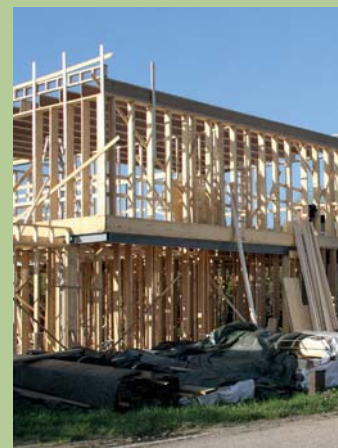
Villa under opførelse
